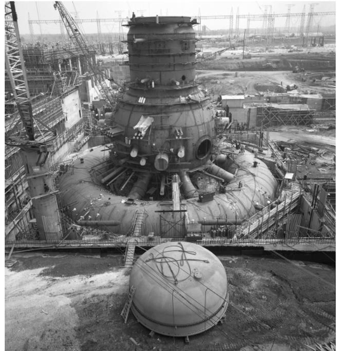
beim Mark-I-Typ im Gegensatz zum übrigen Reaktor-gebäude nur durch eine dünne Stahlwand und nicht durch dickere Betonwände begrenzt. Das Reaktor-gebäude ist etwa 50 m hoch. In Abbildung 5 rechts ist der Sicher-
